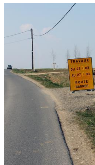
La RD 56 sera fermée par tronçon pendant la durée du chantier. Photo RL
